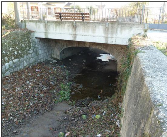
Foto 9 - Riduzione della luce a seguito del rivestimento del fondo alveo in corrispondenza opera CA03.
