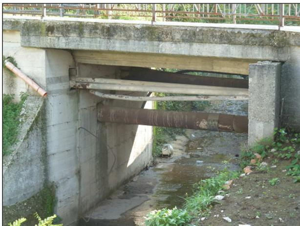
Foto 11 - Riduzione della luce per la presenza di sottoservizi in corrispondenza dell'opera CA10 sul Torrente Castello.
