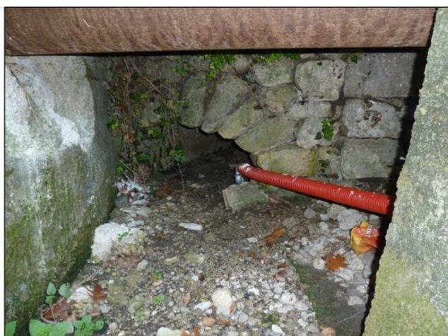
Foto 8 - Riduzione sezione di un vecchio ponticello su affluente in destra del torrente Castello (CADX08).
