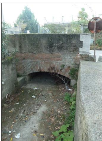
Foto 7 - Riduzione della luce a seguito del rivestimento del fondo alveo in corrispondenza opera CADX04.
